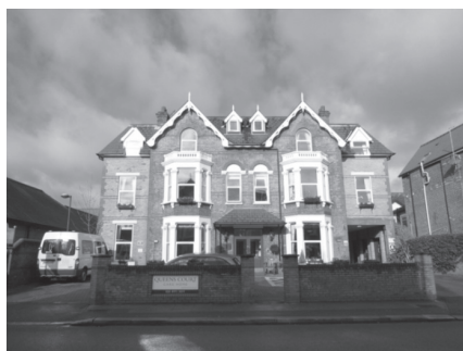
写真4. Queens Court の外観
